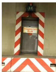
紧急疏散楼梯
