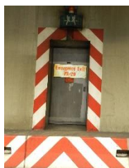
紧急疏散楼梯
