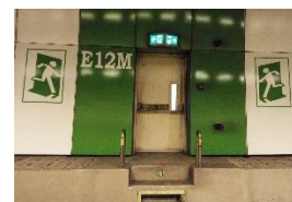
加冷-巴耶利峇高速公路（KPE）/滨海高速公路（MCE）：发生紧急状况时，请注意以蓝白色频闪灯作为引导标志的绿色墙壁处的紧急疏散楼梯和横道通门。
