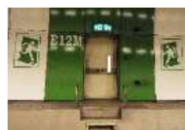
加冷-巴耶利峇高速公路（KPE）/滨海高速公路（MCE）：发生紧急状况时，请留意以蓝白色频闪灯作为引导标志的绿色墙壁处的紧急疏散楼梯和横道通门。
