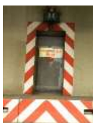
紧急疏散楼梯
