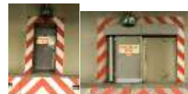
中央高速公路紧急疏离楼梯出口 中央高速公路横道通门
